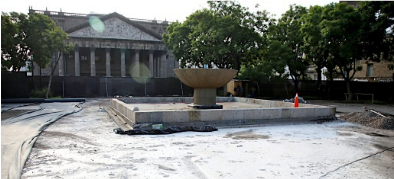
La Plaza Liberación está en proceso de restauración dentro del paquete de obras de los Perímetros A y B.
